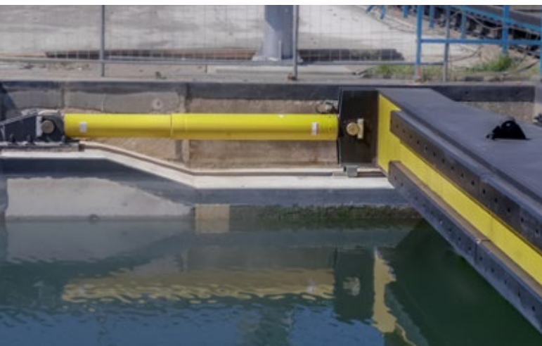
Dämpfung für Zugkupplung // Damping for train coupling
